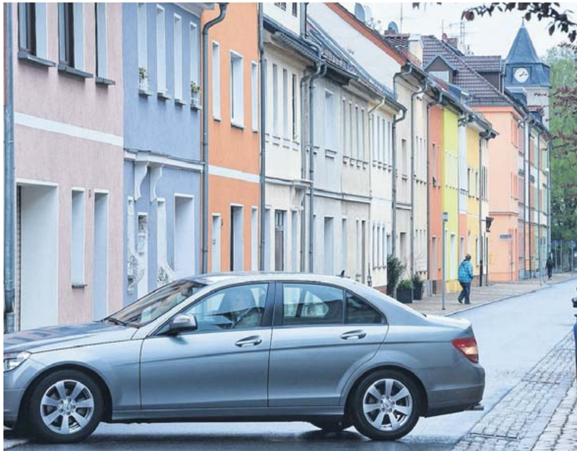
Die Wilhelmstraße im Glauchauer Wehrdigt präsentiert sich im sanierten Zustand.
